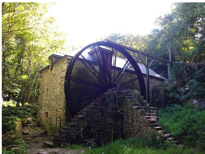
*Le Moulin de Kériolet (Finistère) avec sa roue à augets de 8 m de diamètre*
