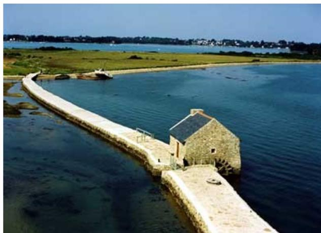
Compte tenu de son mode de fonctionnement, le moulin à marée ne peut fonctionner que durant une partie de la journée, lorsque le niveau de la mer est plus bas que celui du bassin, entre 6 heures toutes les 12 heures suivant le moulin. Cette durée est plus courte lorsque le coefficient de marée est faible.
